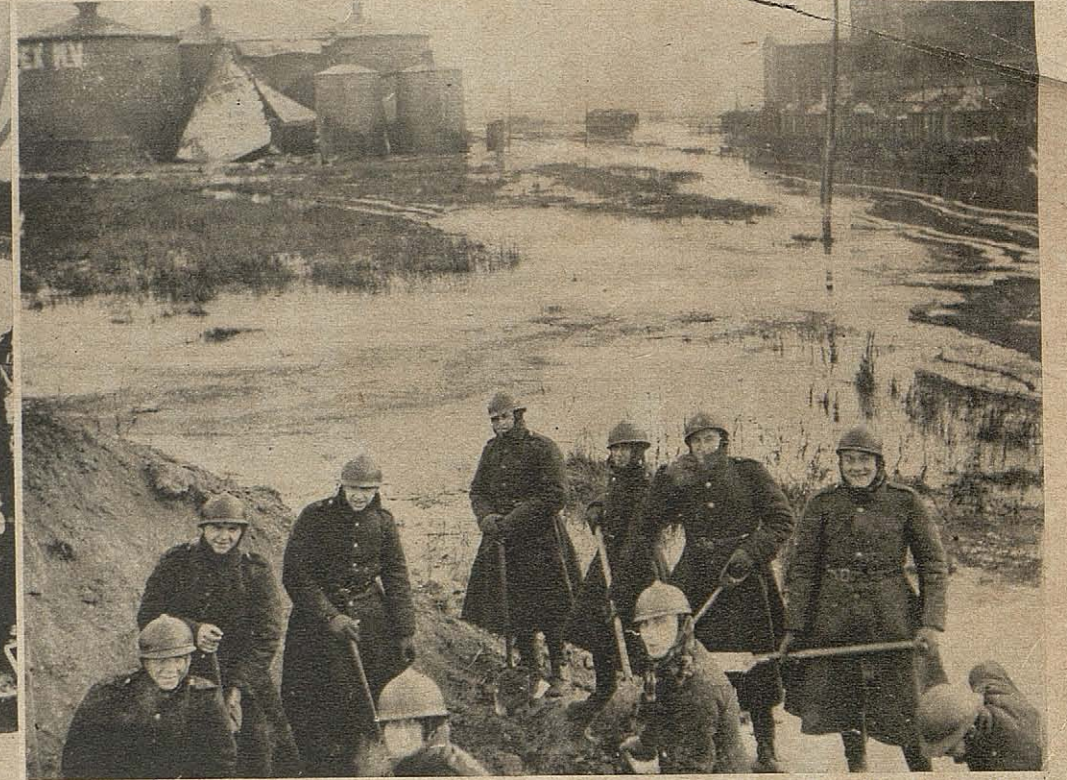
TANKS GESPRONGEN TE ZEEBRUGGE. — De hevige koude veroorzaakte een zonderling ongeval te Zeebrugge. Een tank, die 4.200 ton melasse inhield, is gesprongen en de dikke, slijkerige massa verspreide zich op den grond, haalde een omheiningmuur neer en trok nog twee andere tanks en met melasse en een met creosote — omver. Soldaten groeven putten, waarin de melasse en de creosote konden worden bedolven.
